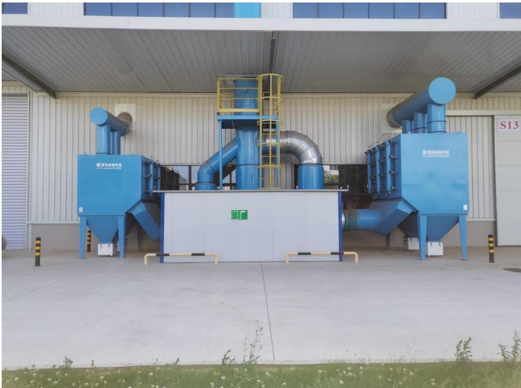
图 4-1 焊接工序除尘器
