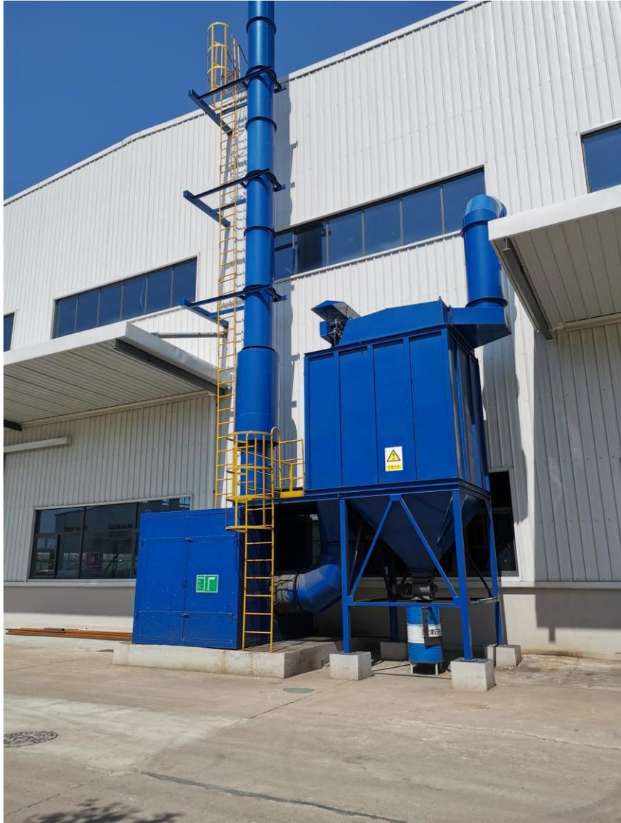
图 4-2 抛丸工序除尘器
