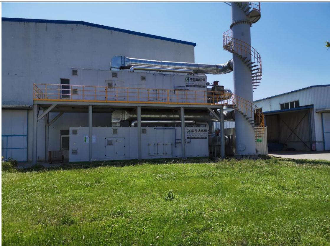
图 4-4 喷涂工序废气处理装置
