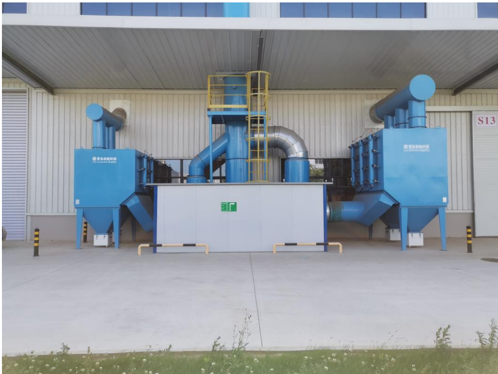
图 4-1 焊接工序除尘器
