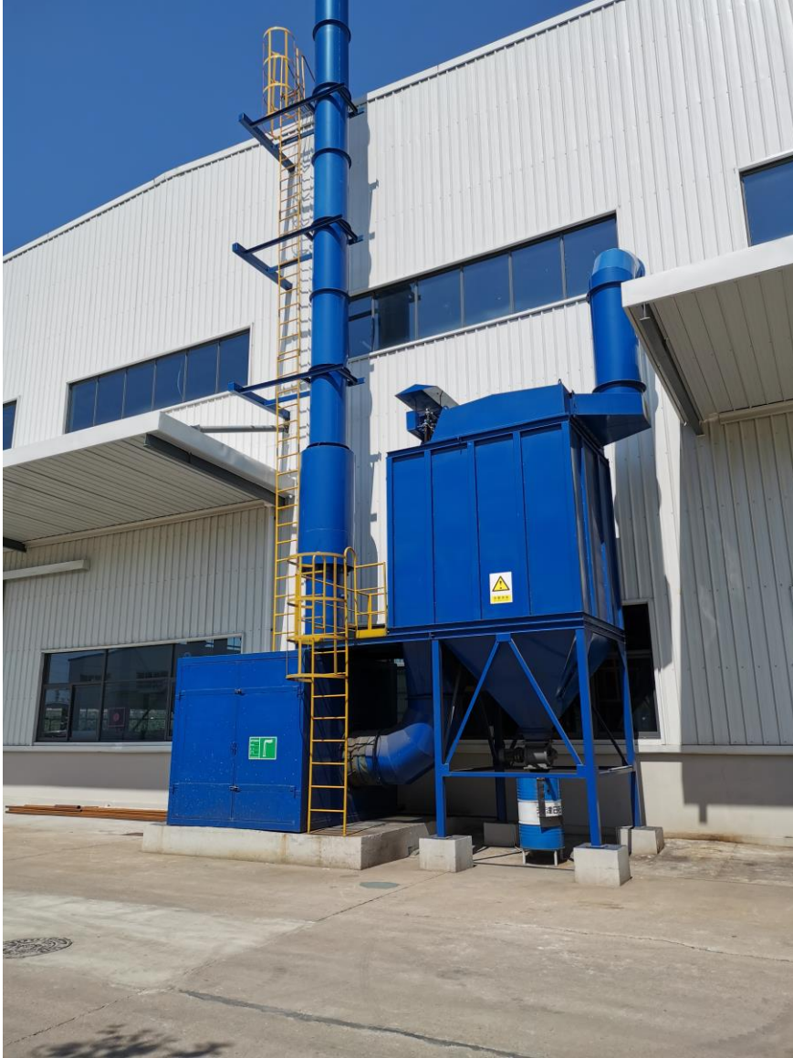
图 4-2 抛丸工序除尘器
